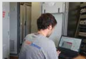
Ввод в эксплуатацию
