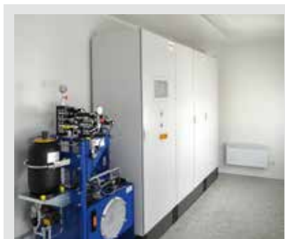
Нет необходимости в машинном зале Небольшая нужда в площади для второстепенных устройств, как шкаф управления и маслонапорная установка
